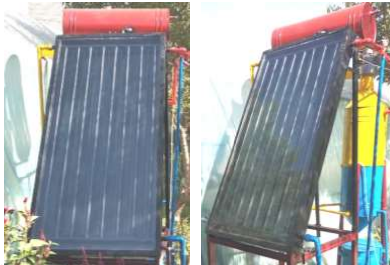
Рис. 2. Общий вид комбинированного солнечного коллектора с контактным теплообменником
