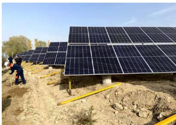
Рис.3. Монтаж ФЭС мощностью 50 кВт для системы водоподъема в Янгикурганском тумане Наманганской области, село Хакикат
