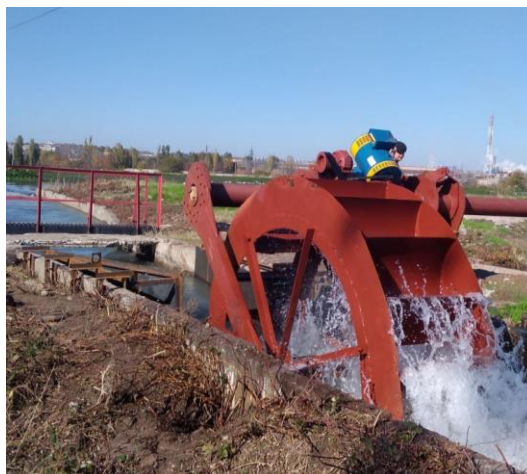
Рис.2. Процесс испытания новой конструкции микроГЭС
