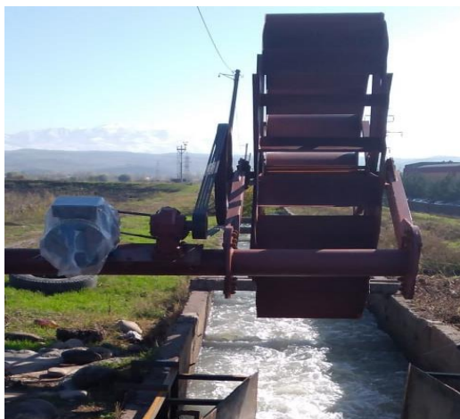
Рис.1. Установленная свободнопоточная микроГЭС на бетонном лотке (поток очищенной сбросной воды города Чирчик)
